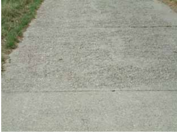
3 Oberflächenschaden, Entmörtelung
