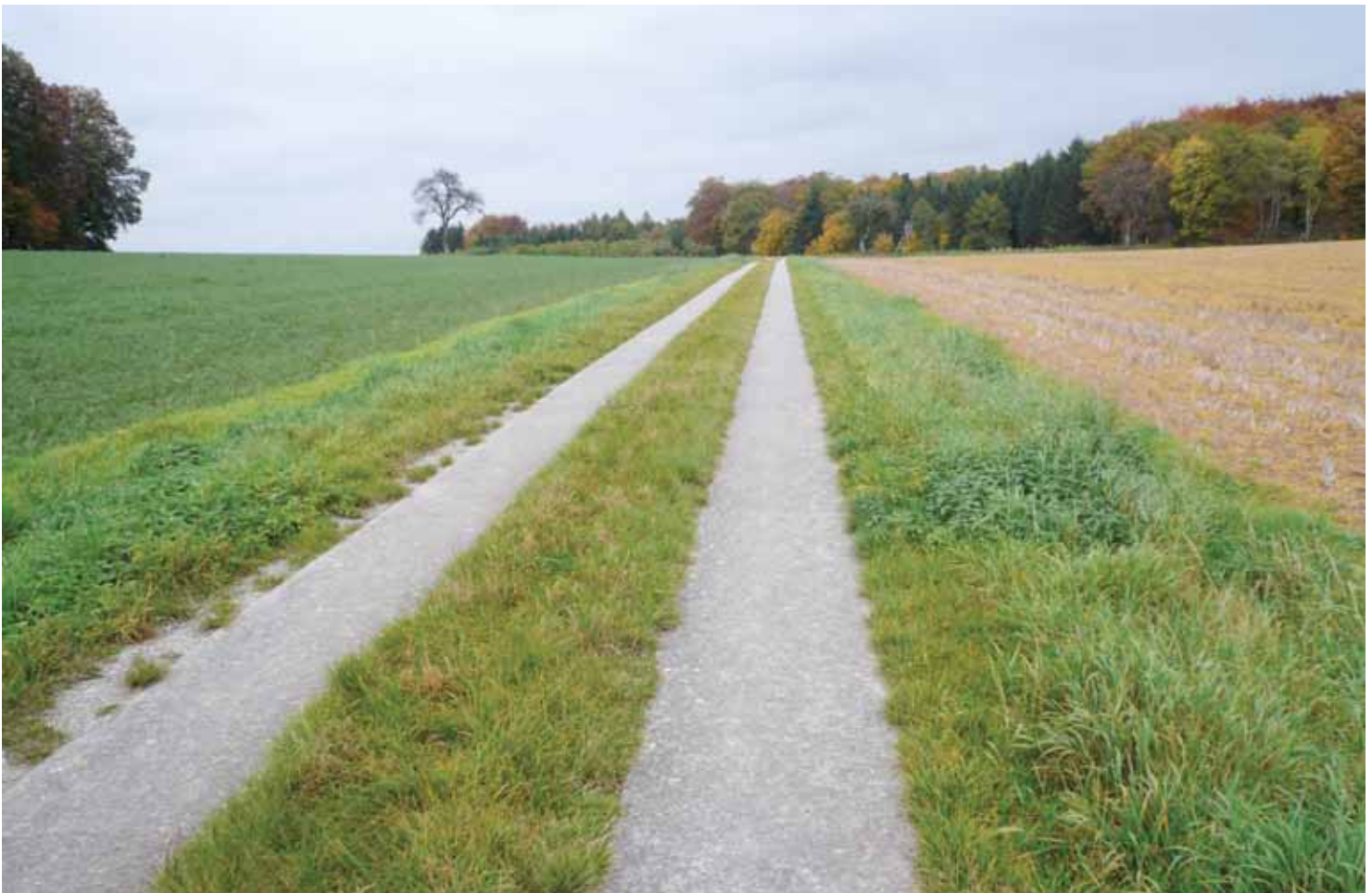
1 Spurweg aus Beton
