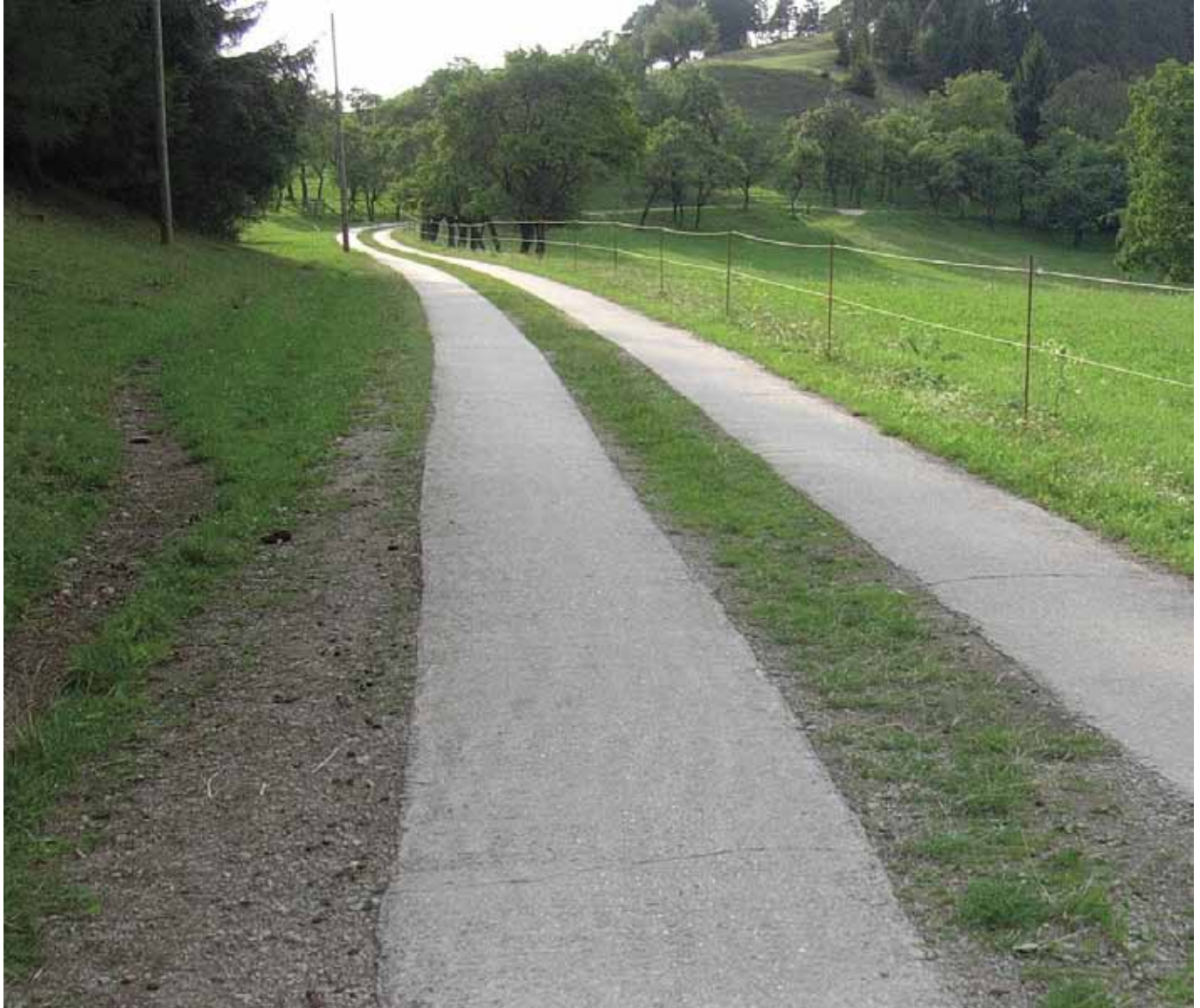
13 Gut erhaltender Betonweg
