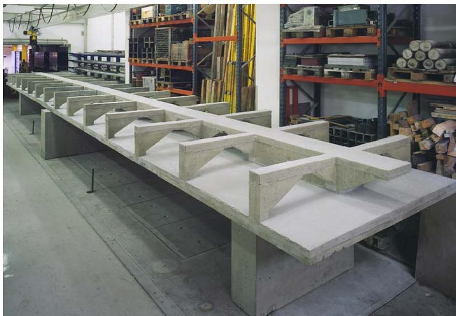
Abbildung 2: Rippenstruktur Decke für Installationen © Pez Hejduk
