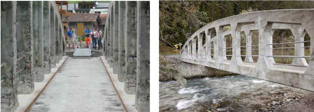
Bild 2: Die Landquartbrücke Dalvazza vor und nach der Instandsetzung
