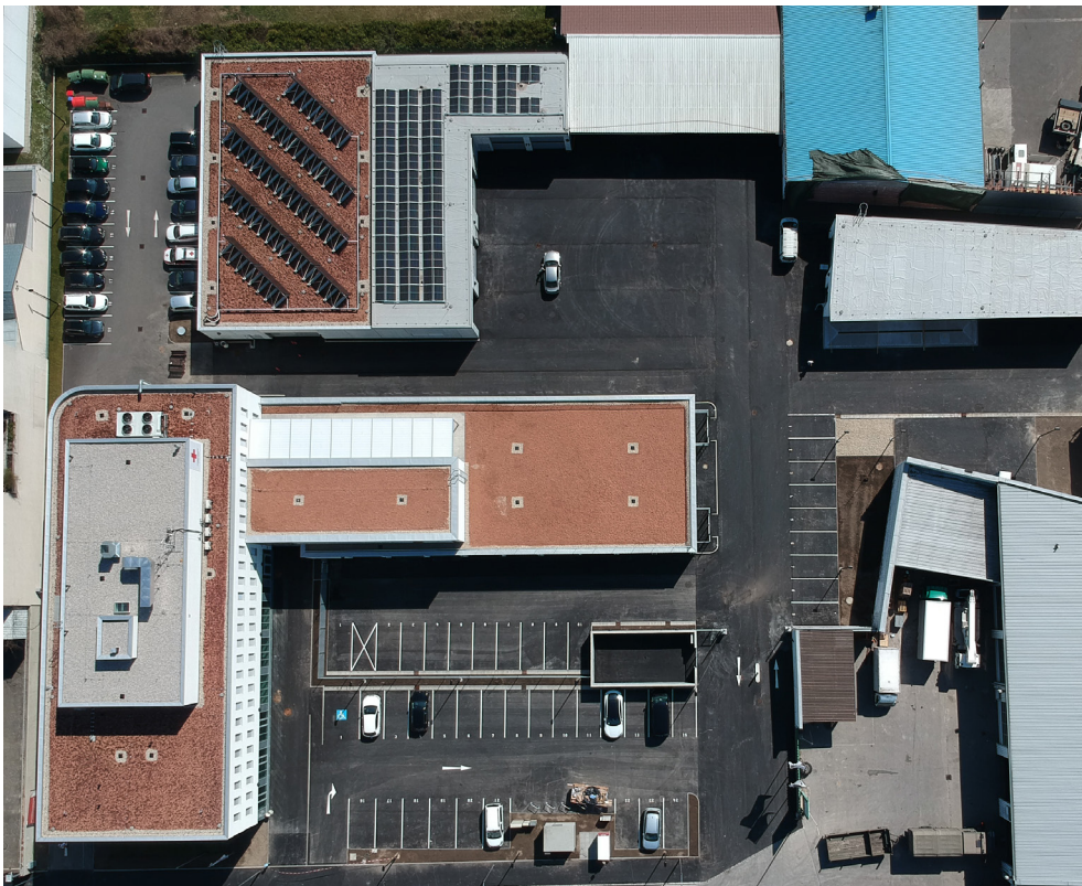
Eine 100 Quadratmeter große Solaranlage und eine PV-Anlage sind neben der Wärmepumpe die Grundlage der Energieversorgung.
