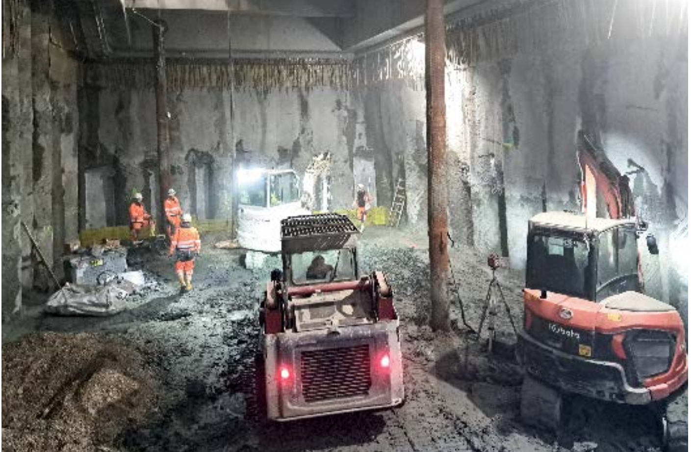
Aushubarbeiten Schacht Siebenbrunnengasse
