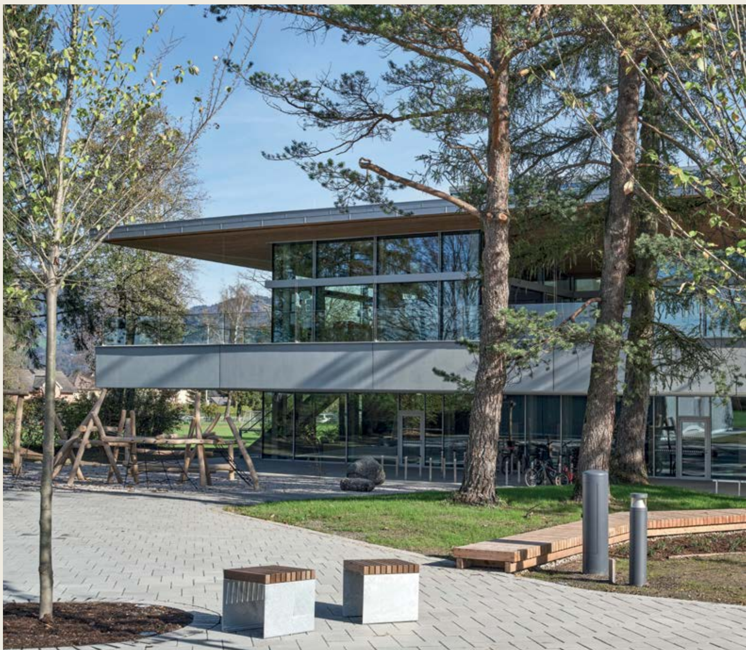
Prototyp Volksschule Anif – hier setzte der Bauträger Salzburg Wohnbau erstmals Recyclingbeton und den Klinkerreduzierten Zement CEM II/C ein.
