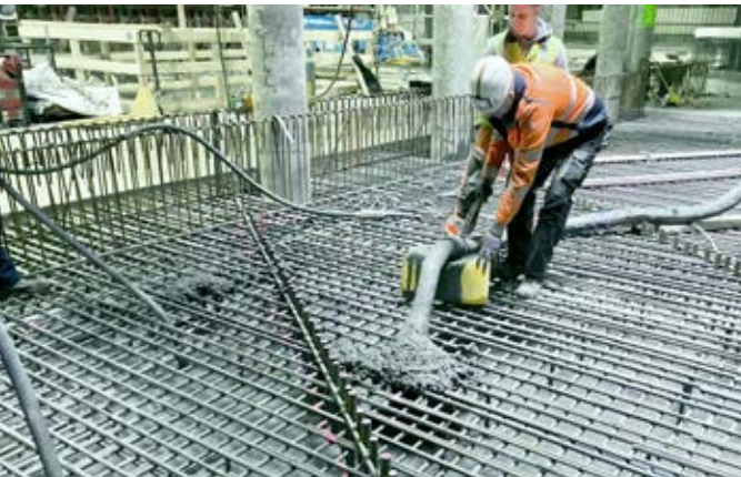
Präzisionsarbeit: Die Betonage der Bodenplatte im Schacht am Bacherplatz
