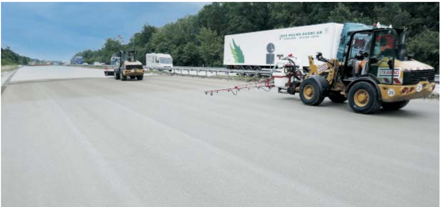
Die fertige Betondecke der A9, Anschlussstelle Niemegk, Richtungsfahrbahn Leipzig/München, wird noch für eine lange Lebensdauer zum Abschluss besprüht.
