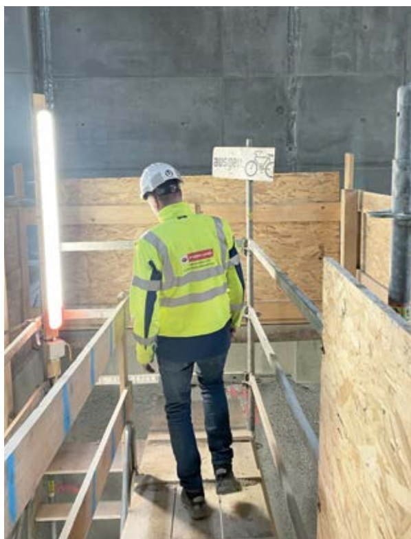
Ab in den Untergrund – die Wände sind bereits fertiggestellt.
