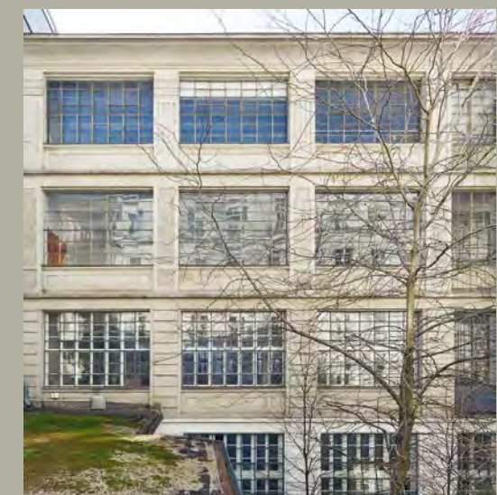
Bild: Einer der frühen Eisenbetonbauten Wiens.
