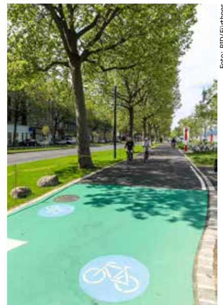
Der Mega-Radhighway in der Lassallestraße
