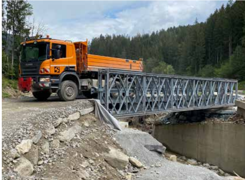
Behelfsbrücke auf der L46
