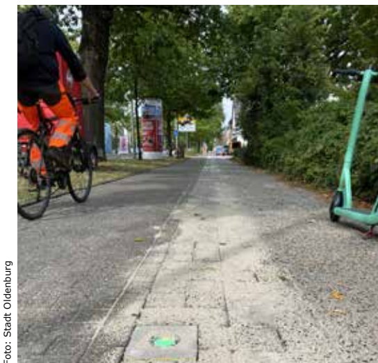
Foto: Stadt Oldenburg Fußgänger- und Radfahrerfurt mit detektorbasierter Freigabeverlängerung in Oldenburg
