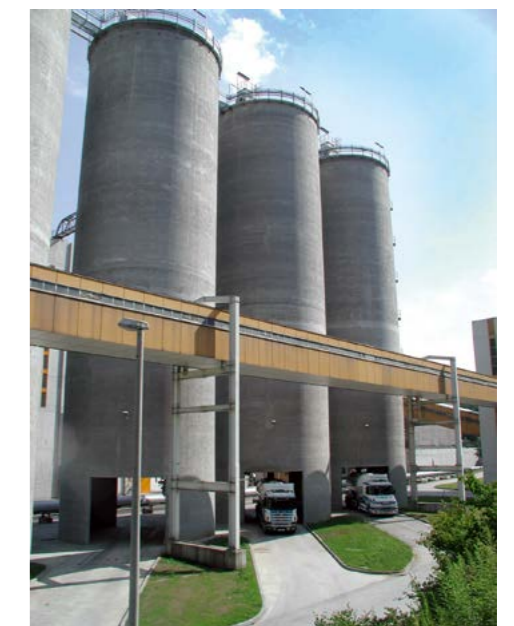
Zementsilos – Lagerung der Produkte
