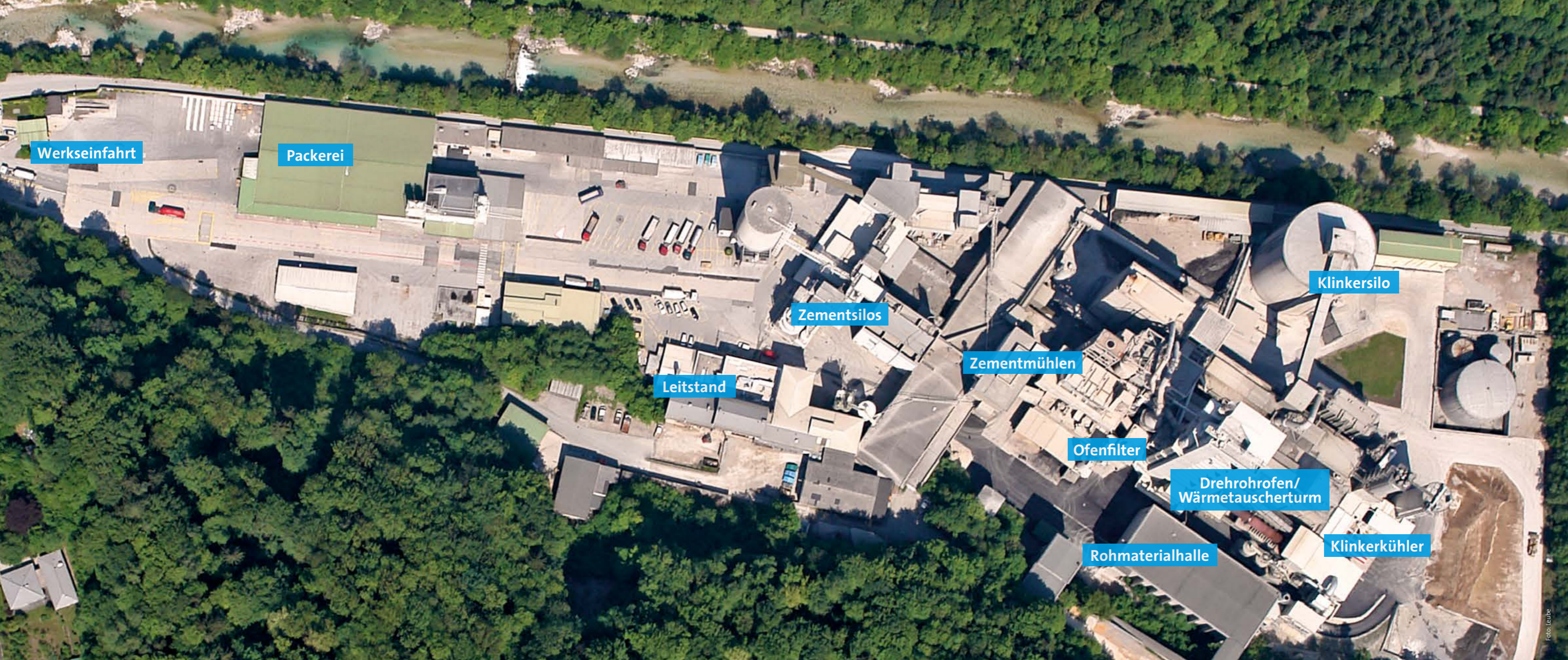
Zementwerk im Überblick
