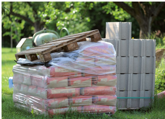
Abb. 1: Ordnung auf der Baustelle erleichtert den Arbeitsablauf.
