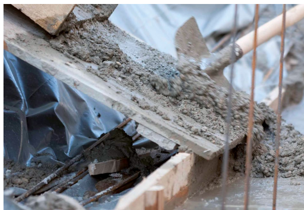
Abb. 20: Frischen Beton sofort verarbeiten
