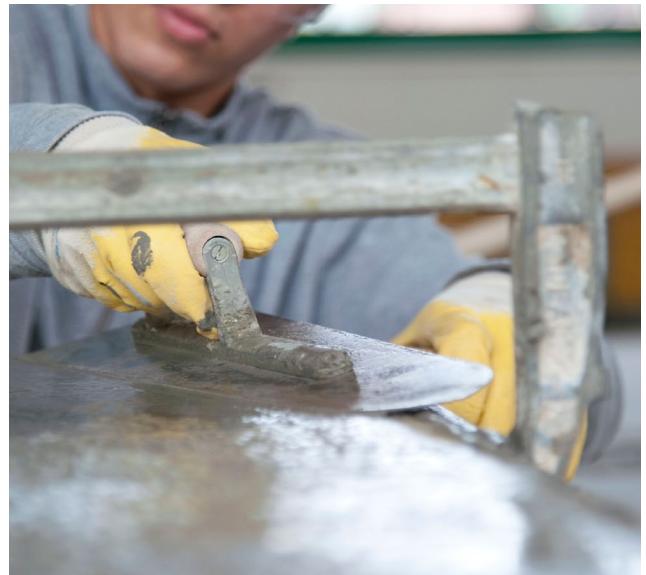
Abb. 23: Falls erforderlich kann die Oberfläche unmittelbar nach dem Verdichten geglättet werden.
