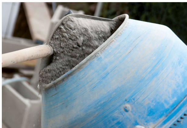
Abb. 17: Zement in den Mischer geben
