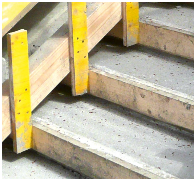
Abb. 25: Schalungen so lange wie möglich belassen
