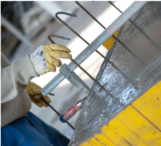
Abb. 22: Steckisen gewährleisten die Verbindung zwischen Betonierabschnitten.
