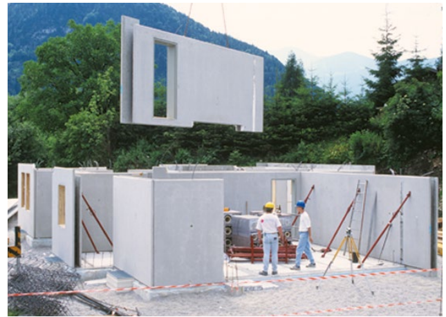
Abb. 28: Kranabladung von Betonfertigteilen
