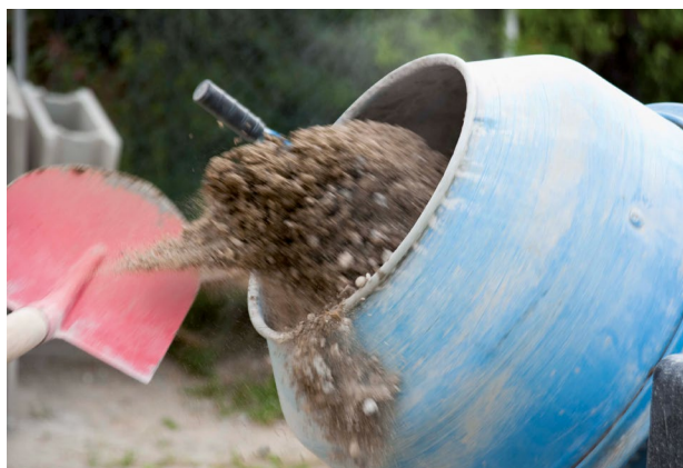
Abb. 16: Geringe Menge Korngemisch in den Mischer geben
