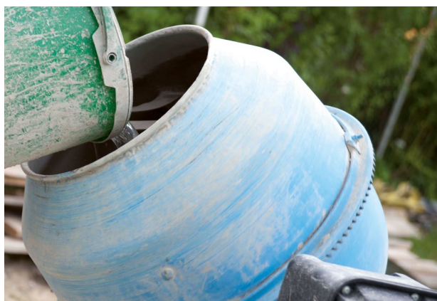
Abb. 15: Wasser in den Mischer geben
