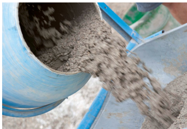
Abb. 18: Frischbeton mit einer Scheibtruhe transportieren
