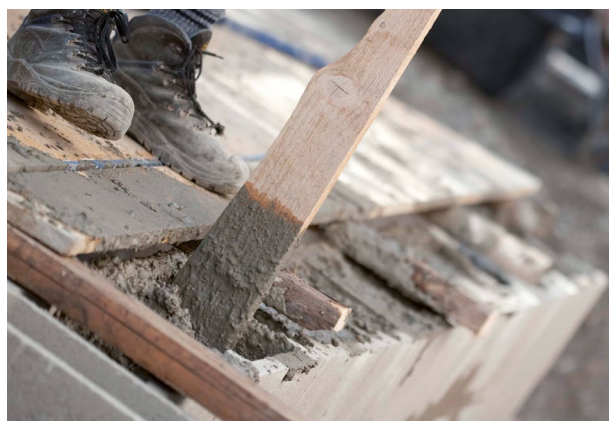
Abb. 21: Sorgfältige Verdichtung ist wichtig.
