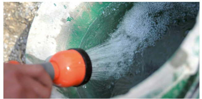
Abb. 5: Sauberes, klares Wasser zum Mischen des Betons verwenden.
