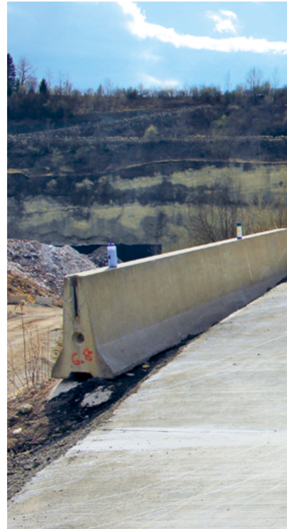
Ein fertiggestelltes Teilstück
