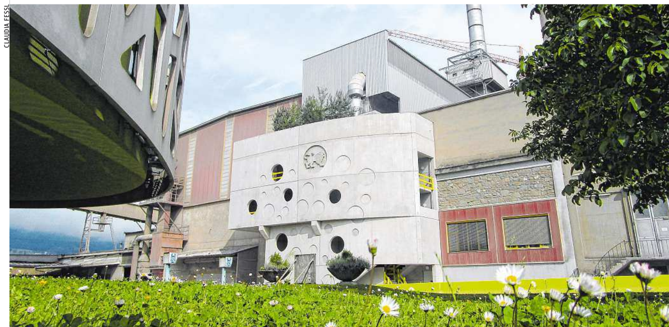
Die DeCONOX-Anlage verbindet industrielle Abluftreinigung mit Wärmerückgewinnung und versorgt 800 Haushalte mit Fernwärme
