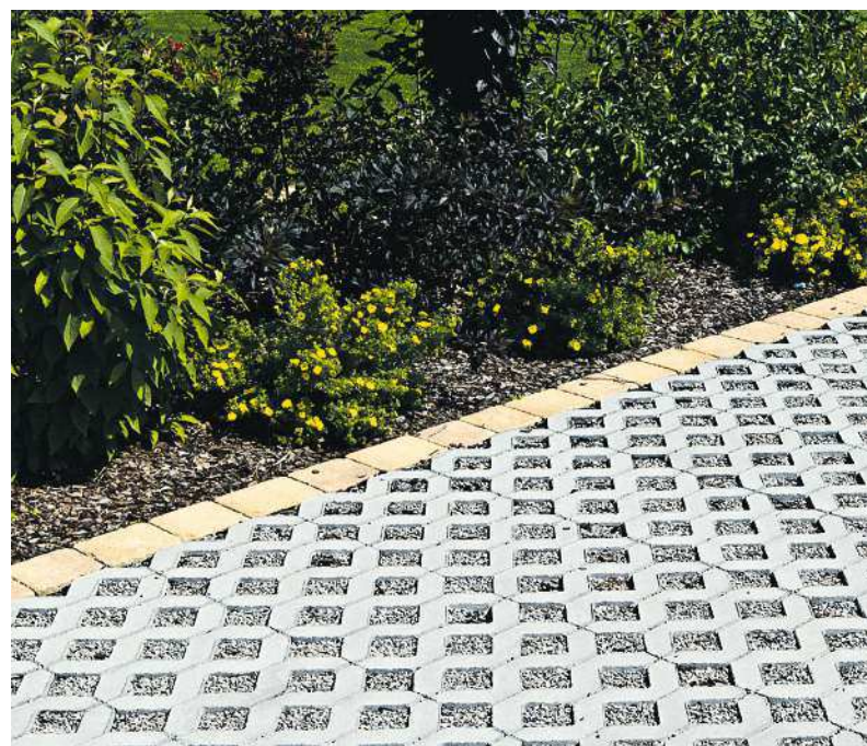
Es gibt bereits eine Menge verschiedener Möglichkeiten, mittels Sickerflächen die Versiegelung des Bodens zu verhindern
