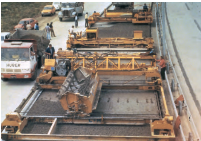
Bild 1: Einbau mit schienengeführtem Gerät in den 1960er Jahren, von hinten: Frontverteiler für Unterbeton, Unterbetonfertiger, Dübelsetzgerät, Seitenverteiler für Oberbeton; nicht sichtbar: Oberbetonfertiger, Nivellierglätter, Arbeitsbühne, Bühne für Auftrag des Verdunstungsschutzes, Arbeits- und Schutzzelte.
