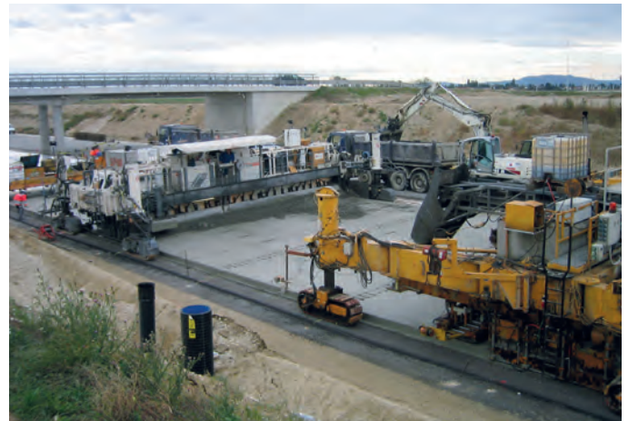
Bild 4: Einbau der Waschbetondecke 2007 auf der S1-Schnellstraße nördlich von Wien
