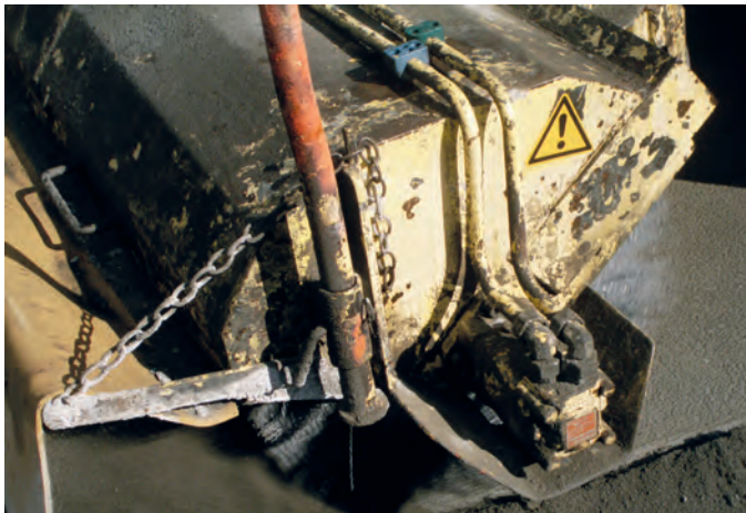
Bild 3: Ausbürsten des Waschbetons ohne Wasser
