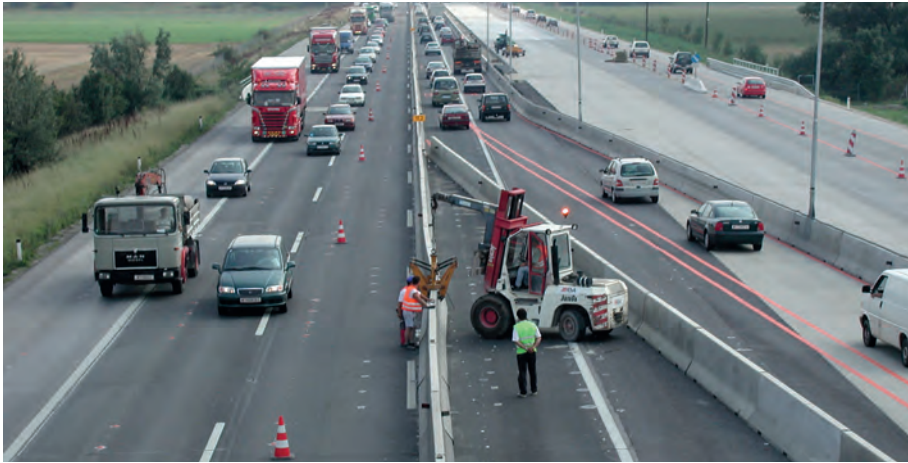
Bild 5: Die Erneuerung einer Betondecke (Bild Autobahnabschnitt Wien – Wiener Neustadt) stellt zusätzliche Anforderungen an die Organisation der Bauarbeiten und der Verkehrsführung.
