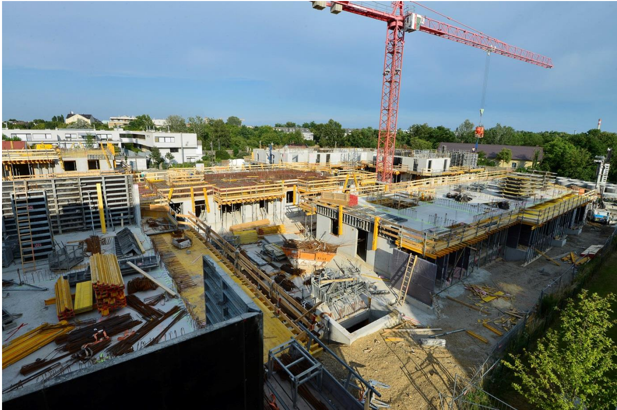
Bild 1: In der Mühlgrundgasse entsteht das erste soziale Wohnbauprojekt mit Thermischer Bauteilaktivierung (TBA) zum Heizen und Kühlen.
