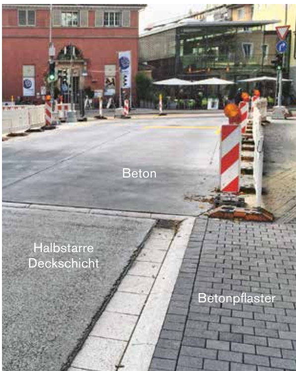
Abb. 3: Drei verschiedene Fahrbahnoberflächen
