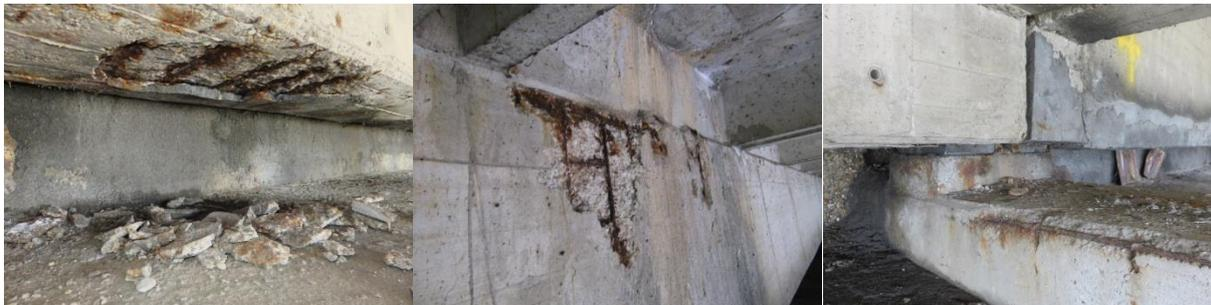
Abb. 3 Schadensbilder der korrodierenden Bauteile
