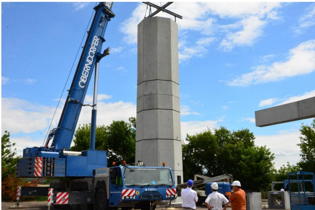
**Abb. 1** Prototyp errichtet mit dem neuen Bauverfahren für Turmbauwerke aus Doppelwandelementen
