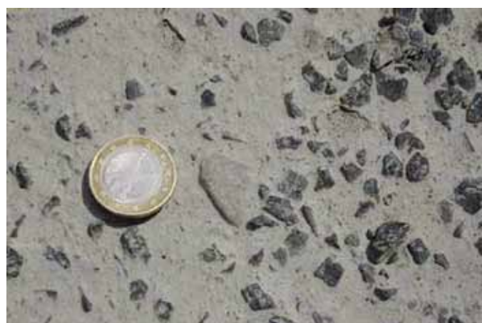
Abb. 2: Betondecke mit fehlerhafter Waschbetonstruktur
