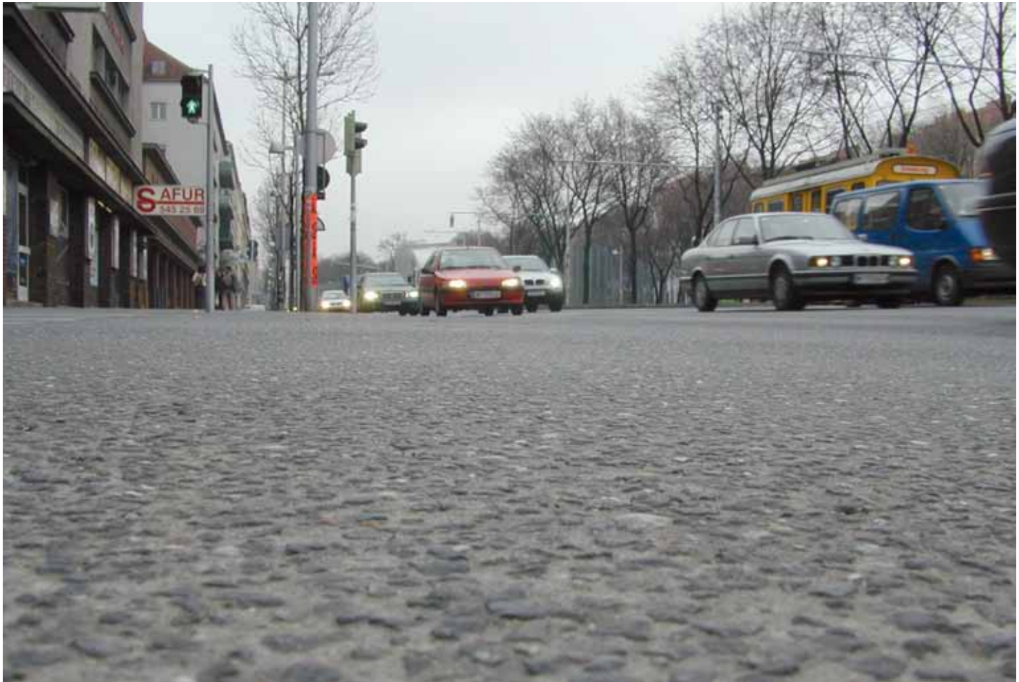
Abbildung 3: Waschbetonoberfläche – Margareten Gürtel, Wien, 2007 Foto: VÖZ
