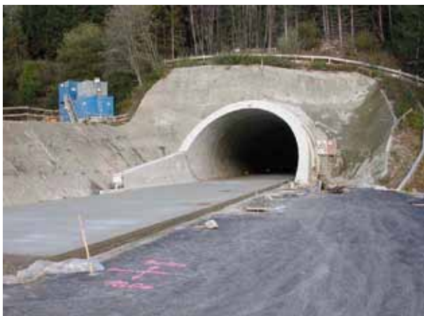
Abbildung 4: Betonfahrbahndecke im Herzogbergtunnel, Südautobahn A2 Foto: VÖZ
