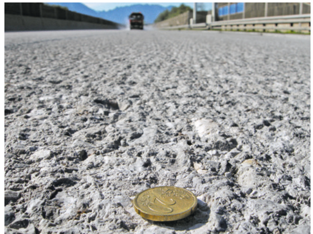
Abb. 5 Oberfläche nach der HDW-Reinigung
