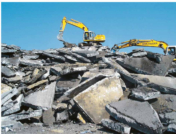
Abb. 1: Zwischenlager des Strassenabbruchs
