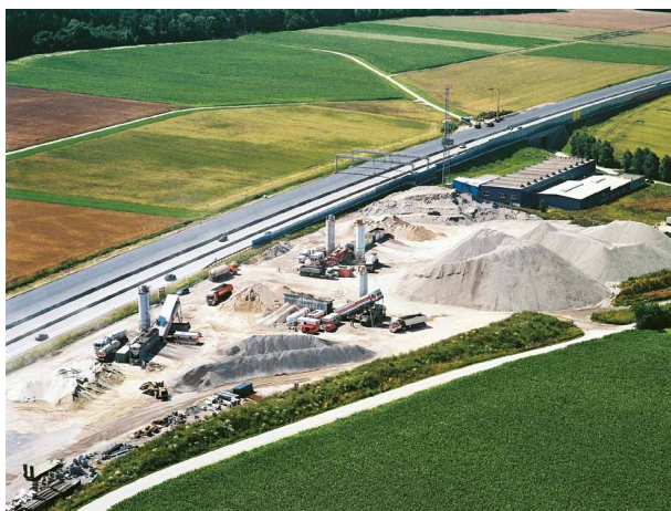
Abb. 3: Mobile Anlage zur Aufbereitung und Zwischenlager
