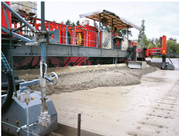
Abb. 6: Betoneinbau (Oberbeton) mit Gleitschalungsfertiger
