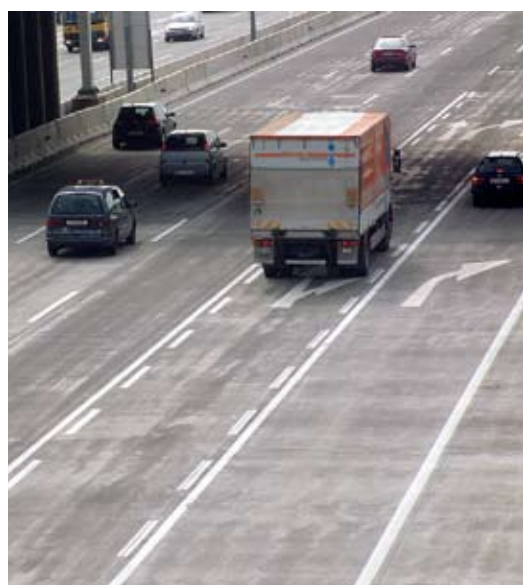
A2 – Knoten Vösendorf, Detail Fahrbahn
