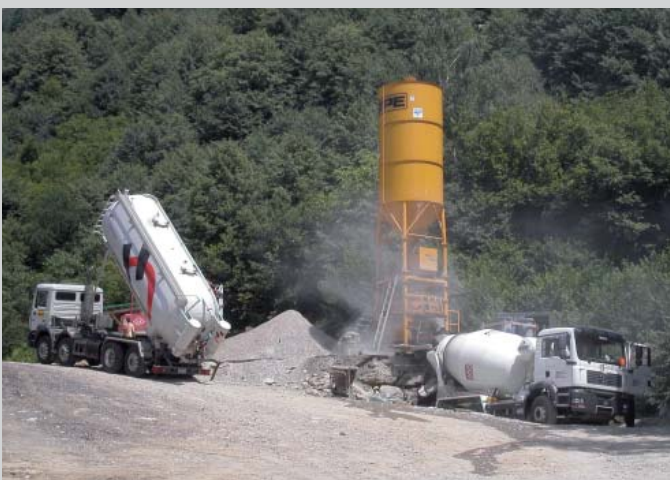
Baustelleninstallation, mobile Betonanlage und Materialdepot
