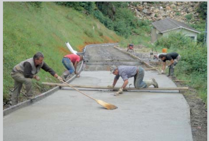
Nacharbeiten: Taloschieren (Glätten mit hölzerner Glättscheibe) und Besenstrich
