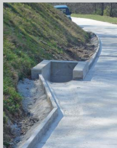
Einlaufschächte für Ableitung des anfallenden Oberflächenwassers
