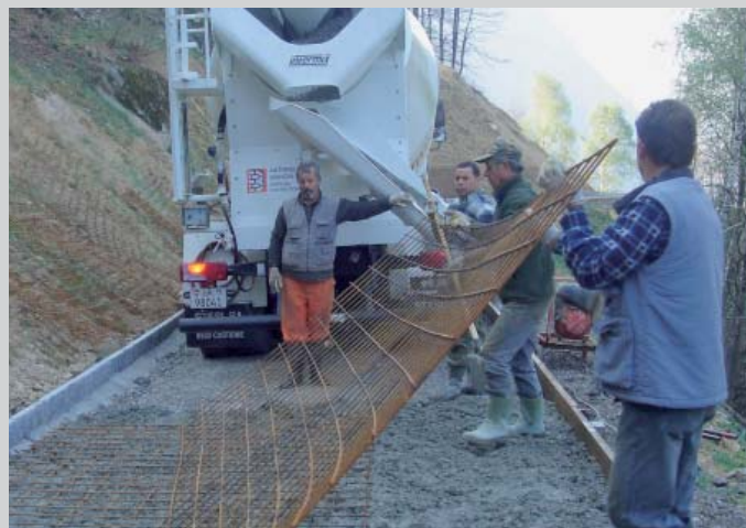
Verlegen der Baustahlgewebematten
