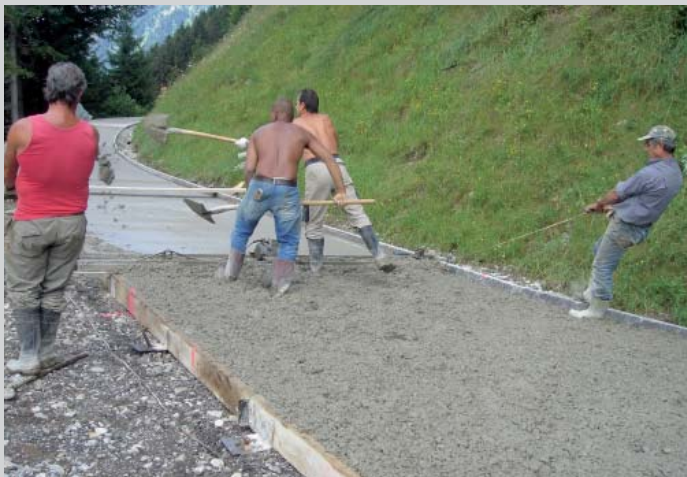
Betoneinbau: Abziehen mit Vibrobalken
