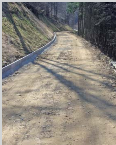
Fertige Rohplanie (bereit für den Betoneinbau)
