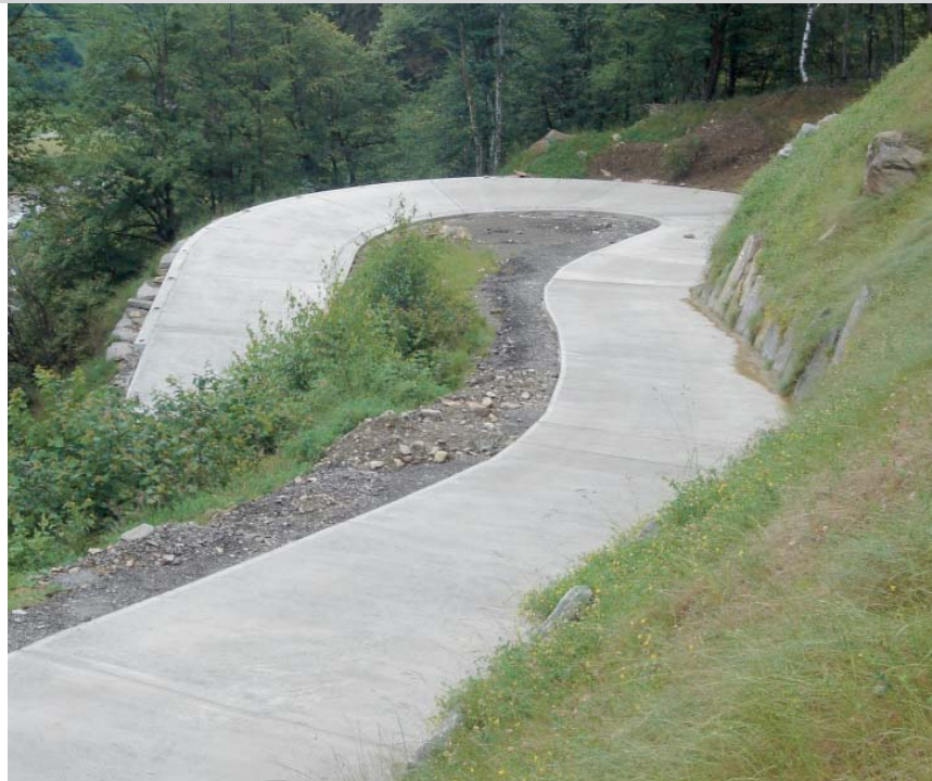
Fertiger Wirtschaftsweg mit Wendepfatten
