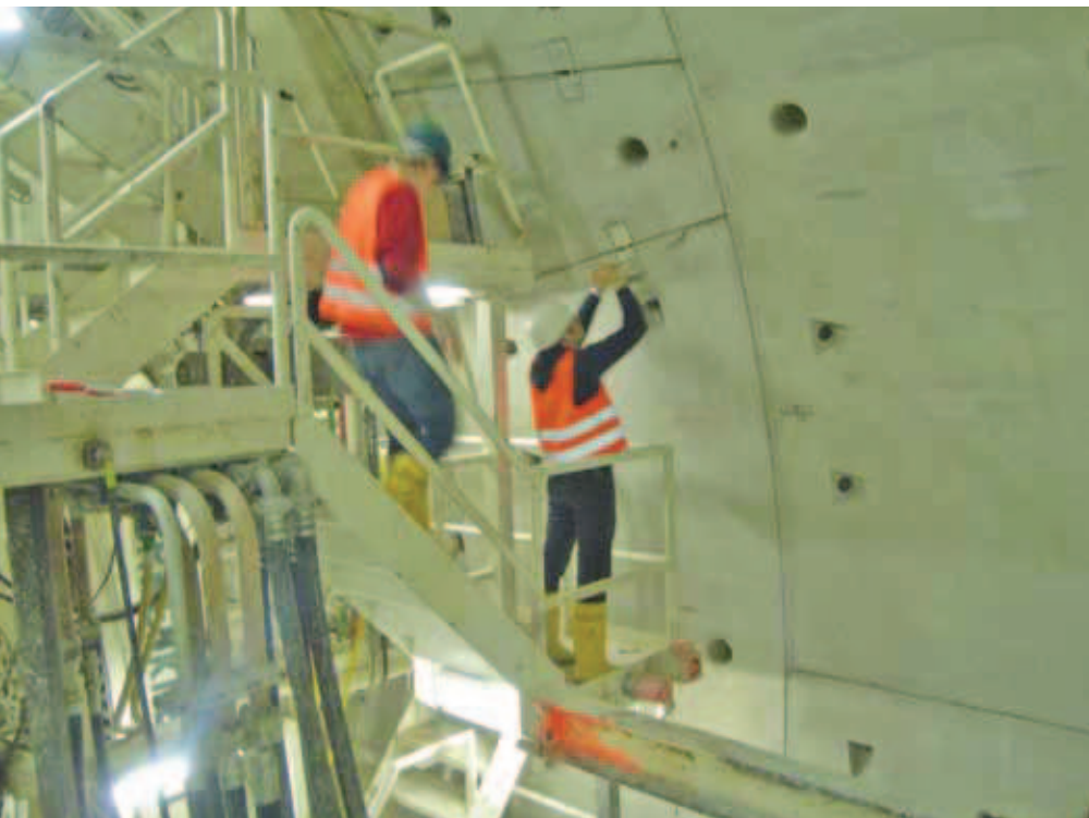
Hinteres Ende der TBM als Arbeitsplattform
