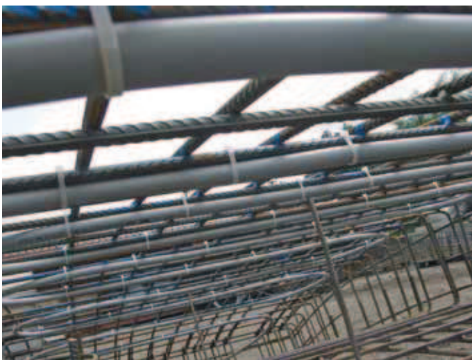
An den Bewehrungskorb angebrachte Absorberrohre
