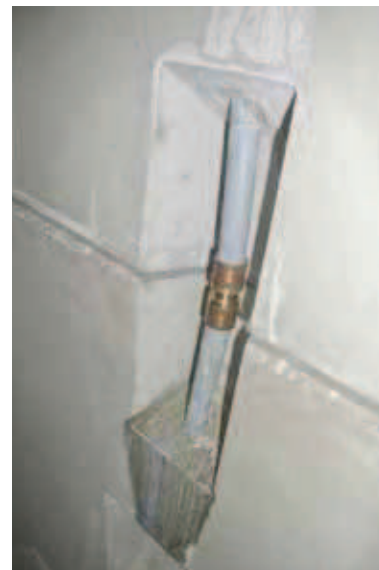
Aussparung mit REHAU Fitting zum Verbinden der Absorberrohre
