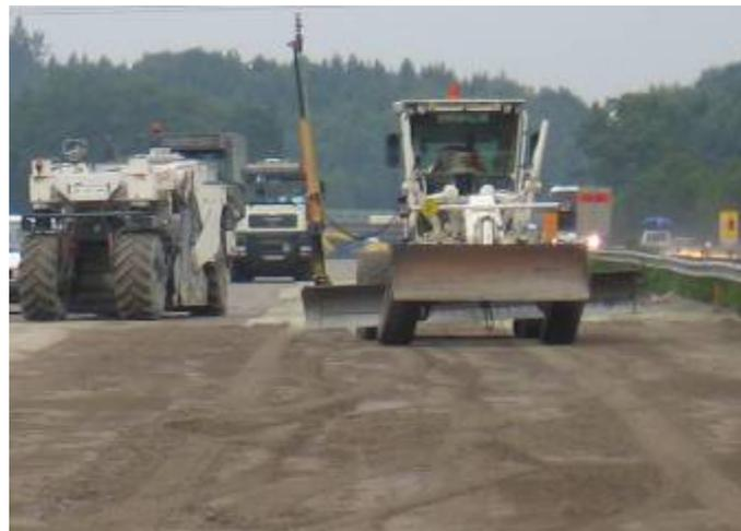
Hinter dem Grader erfolgt die Endverdichtung mit einem zusätzlichen Walzenzug. Bei sandigen Böden hat sich als dritte Walze die Gummirad bewehrt.
