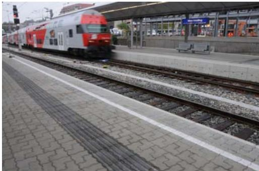
Das dargestellte Blindenleitsystem für den Bahnbetrieb - vor allem für die Bahnsteige - sind in einer eigenen Typengenehmigung mit eisenbahnrechtlichem Bescheid österreichweit zur Anwendung zugelassen. Für die sehschwachen und sehbehinderten Bahnbenutzer sind die taktilen Leitsysteme bevorzugt auch farblich anthrazit vom anderen grauen Bahnsteigpflaster hervorgehoben, so wie der jetzt weiß gehaltene Warnstreifen.
