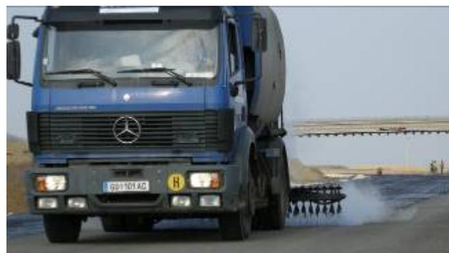
Der Verdunstungsschutz ist lt. RVS mit 0,20 kg/ m<sup>2</sup> Bitumenemulsion aufzubringen. Zur Zeit ist die RVS in Prüfung und im Zuge dieser Prüfung sind alternativen zur Emulsion wie z.B.: ein Verdunstungsschutz möglich.
