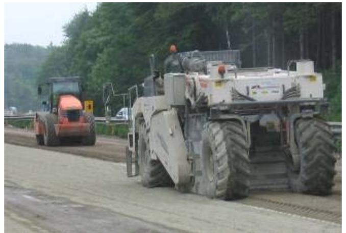
Die Zugabe an Wasser / Emulsion erfolgt automatisch und wird in die Fräskammer eingedüst. Dabei wird das Wasser dosiert aus dem Wasserwagen der vom WR geschoben wird gesaugt.
