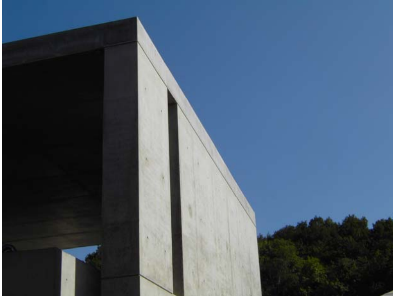
Sichtbeton mit CEM III/A 32,5 R
