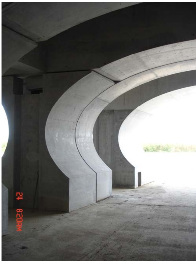
Bild : 1 Stütze - Innenansicht
