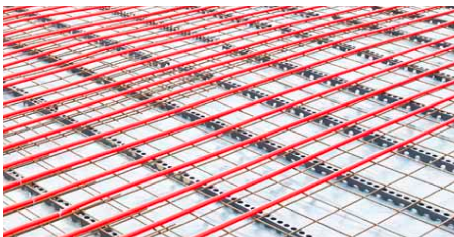
Auf der unteren Stahlbewehrung montierte Leitungsrohre
