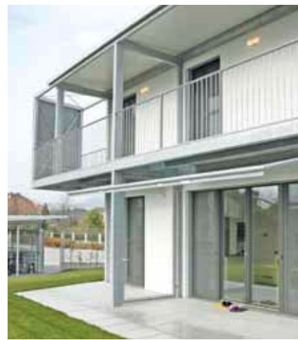
Thermische Bauteilaktivierung in Einfamilienhäusern
