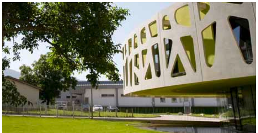
Kirchdorfer Zementwerke: Zukunftsweisender Einsatz des Energiespeichers Beton
