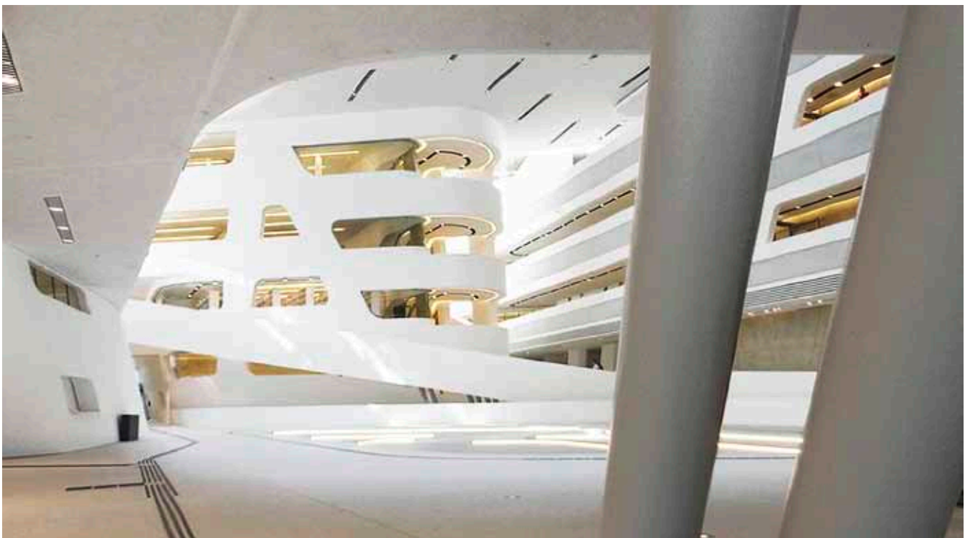
Wirtschaftsuniversität Wien „Library & Learning Center“: Heizen und Kühlen mit thermisch aktivierten Betondecken
