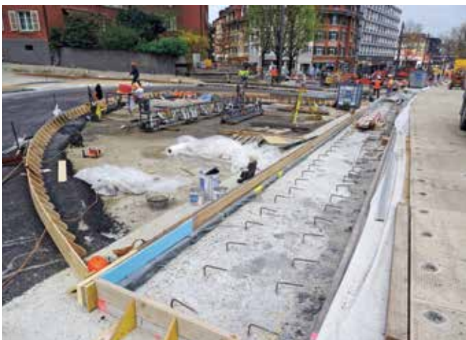
Betonieren der Randstreifen des Gleisbaus im Verbund.
