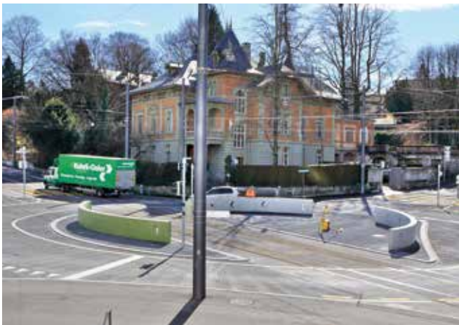
Der neu gestaltete Eigerplatz mit den auffälligen Leitelementen.
