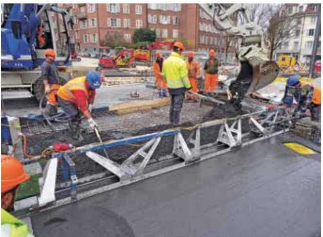
Einbringen des Betons der zweiten Etappe.
