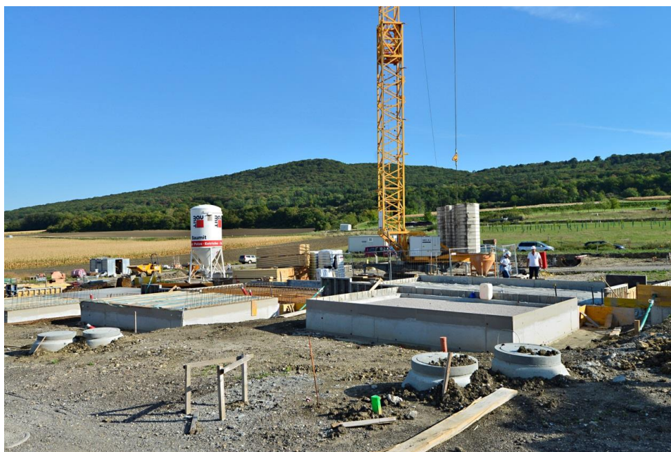
Bild 1: Errichtung der Reihenhäuser, Wohnpark Wolfsbrunn in Sommerein, September 2018 ©Zement+Beton/A. Kromus
