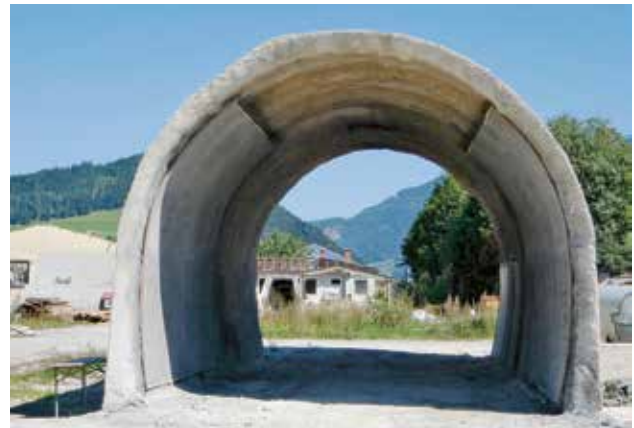
Abbildung 2: Ursprünglicher Versuchstunnel (Quelle: VÖZFI)
