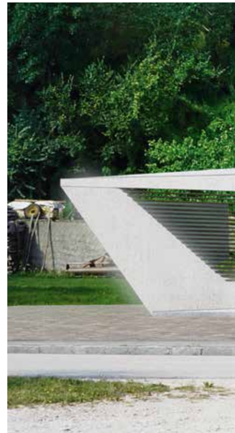
Talstation Aggsbach Dorf
