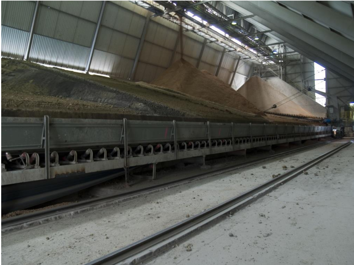
Bild 7-5 Lagerung von alternativen Rohstoffen auf Halden (Beispiel, Quelle: VÖZ)
