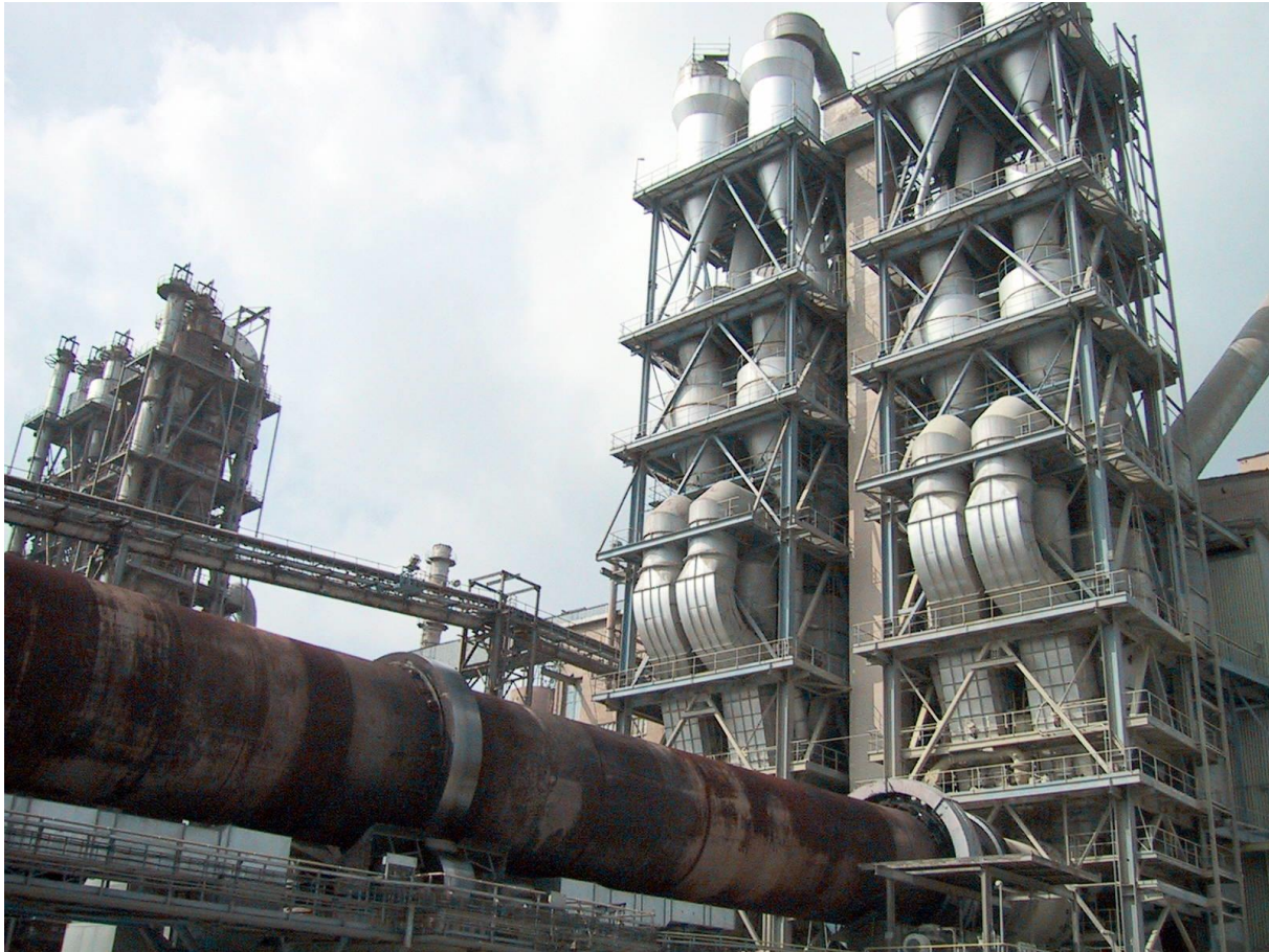
Bild 2-12 Drehofen mit Zyklonvorwärmer (Quelle: VDZ)
