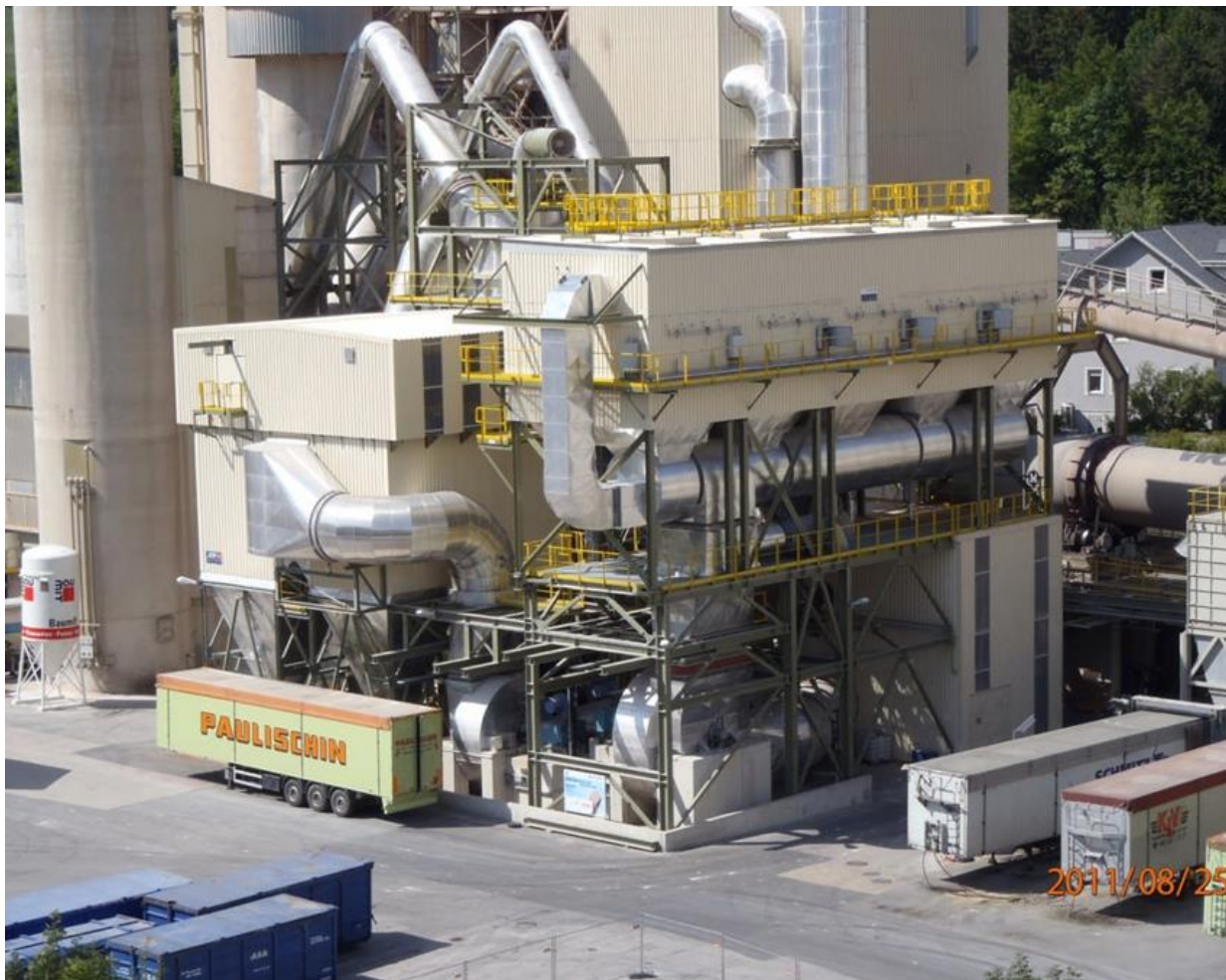
Bild 6-2 RTO-Anlage in einem österreichischen Zementwerk (Quelle: Wopfinger Zement)
