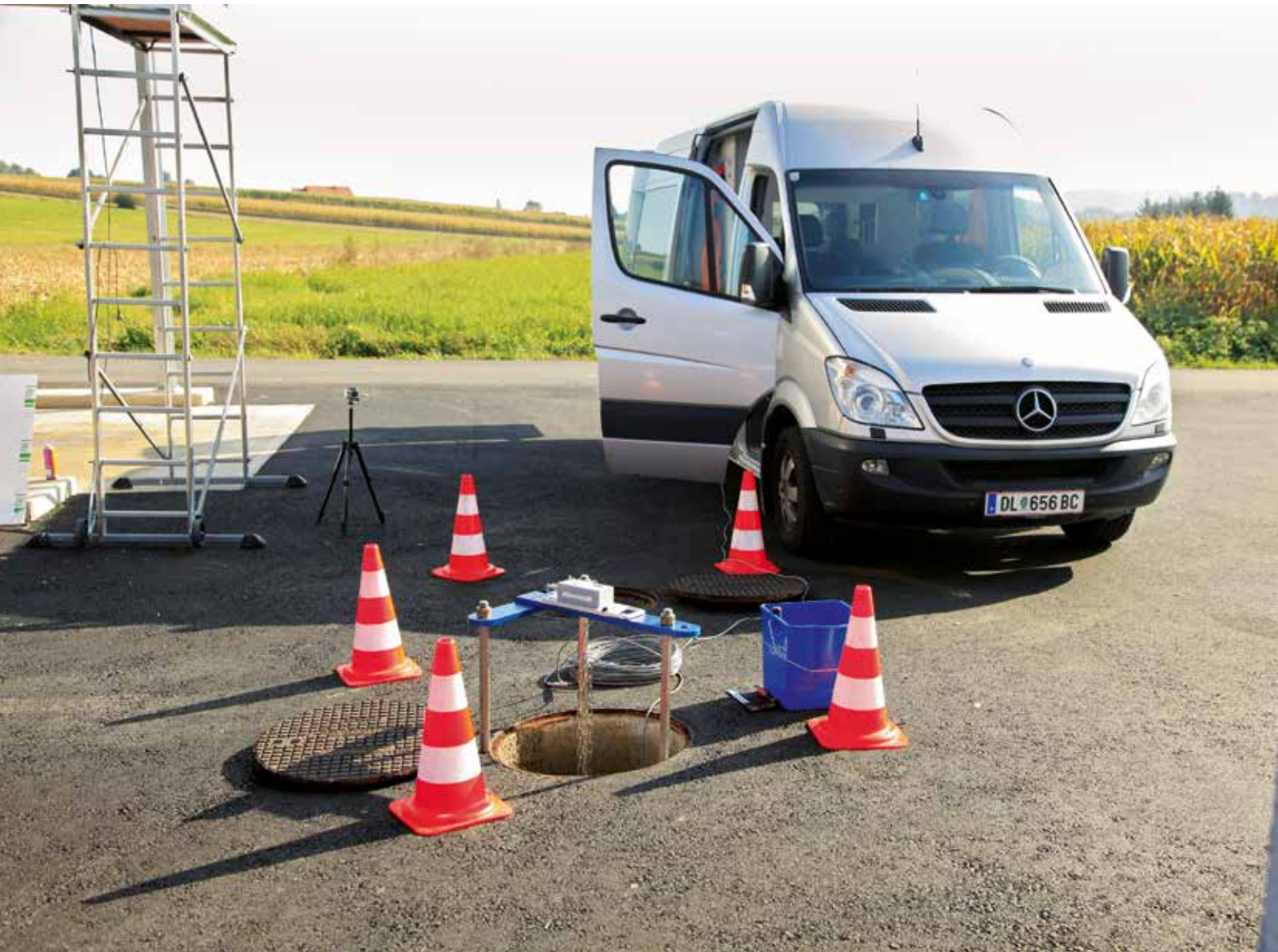
Behälterprüfung (hier Ölabscheideranlage) gemäß Pkt.: 6.5.5
