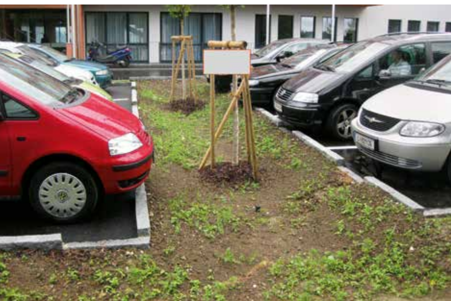
Bild 6: Beispiel für die Gestaltung einer Versickerungsmulde bei Parkflächen
