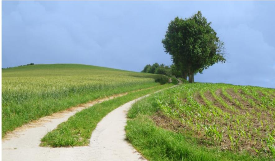
Betonspurwege haben hohen Verschleißwiderstand und werden in naturnaher Bauweise errichtet: betoniert werden nur Spuren zum Befahren mit landwirtschaftlichen Fahrzeugen.
