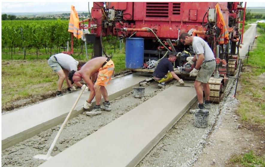
Nur vier Arbeiter bauen bis zu 200 Meter Betonspurwege pro Tag.
